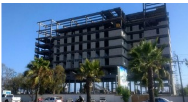
Ett hotell under byggnation
